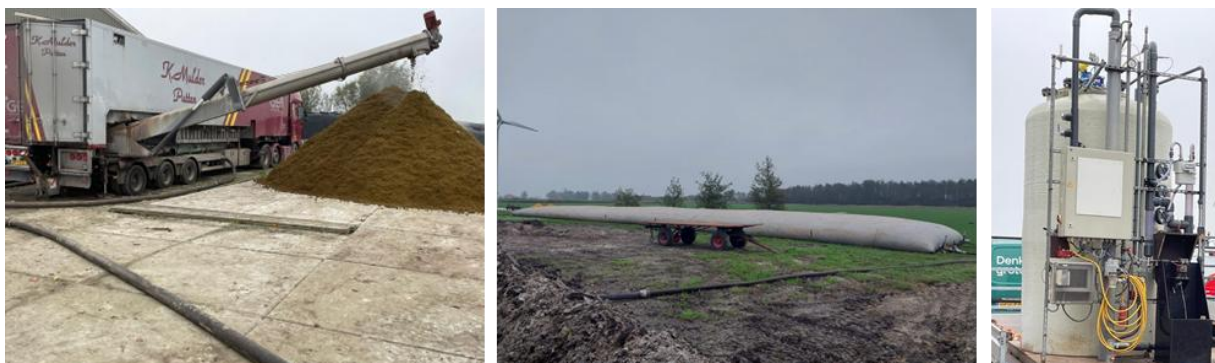
Figuur 3-3. Mestscheiding met een decanter, productie dikke fractie (links), de opslag van dunne fractie (midden) en een 2,5 m 3 vergistingsinstallatie ten behoeve van dunne fractie vergisting (6 november 2025).
